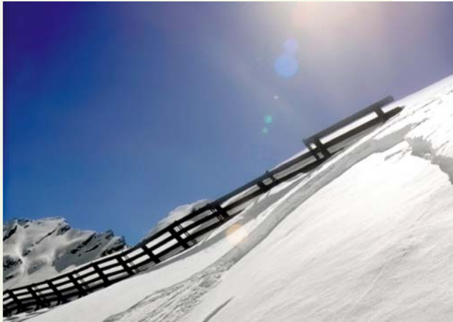
Lavinové zábrany na začátku oblasti lavinového nebezpečí: I ta nejlepší ochranná opatření skrývají reziduální riziko.
